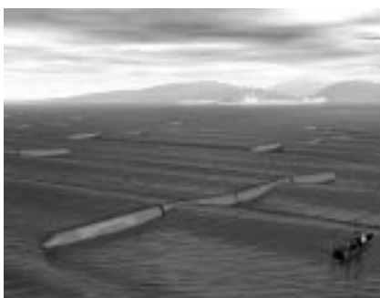
Das schwimmende Wellenkraftwerk von Ocean Power Delivery wird bei Fertigstellung eine Länge von 160m aufweisen.
